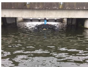
OLOID Typ 400 mit Strömungsrichtung zur Wehrklappe
