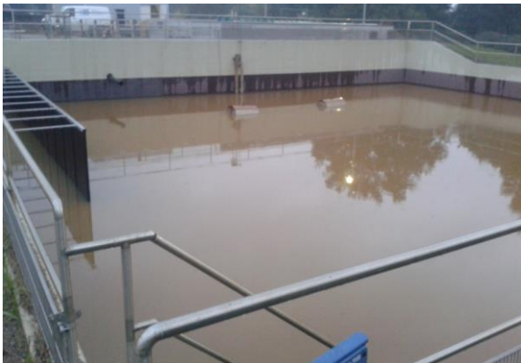
Vor der OLOID-Installation Nach der OLOID-Installation - siehe Bild oben
